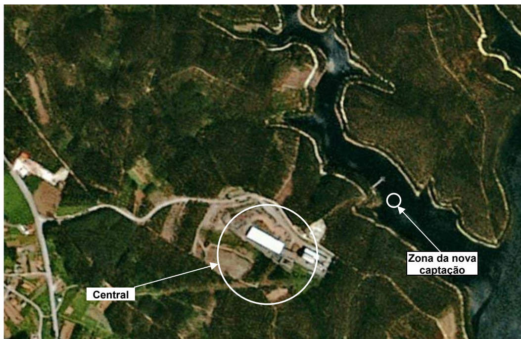
Figura 6.2.2 – Captação de água (2)
